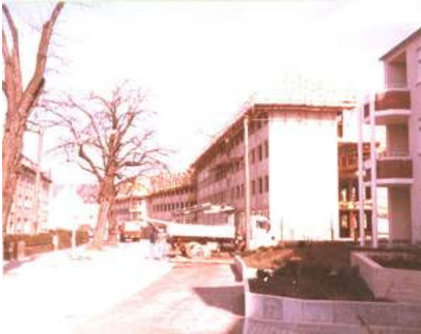
Blick in die Hubert-Neuerburg-Straße
