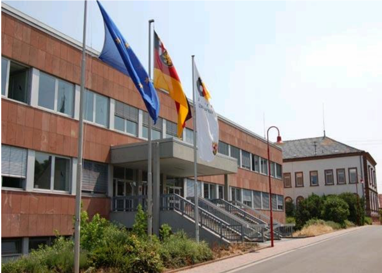
Neubau der FH Edenkoben
